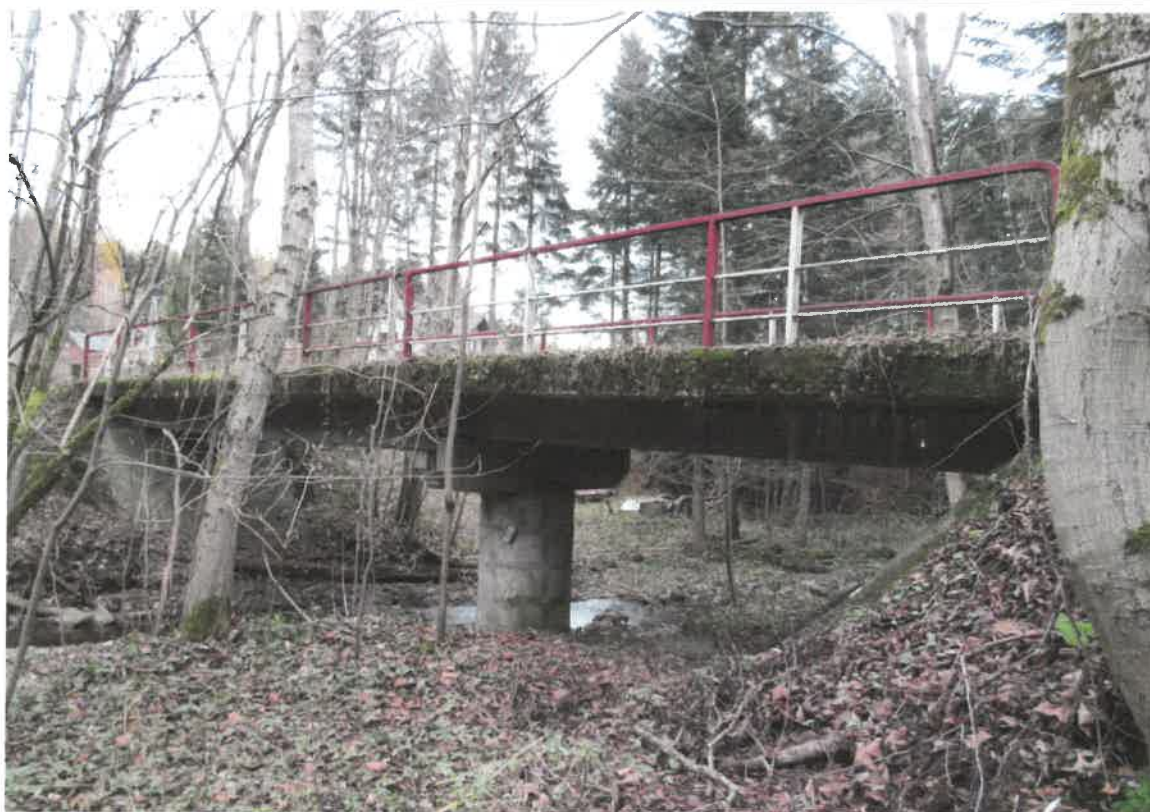
FOT. 1.1 - WIDOK MOSTU Z BOKU
