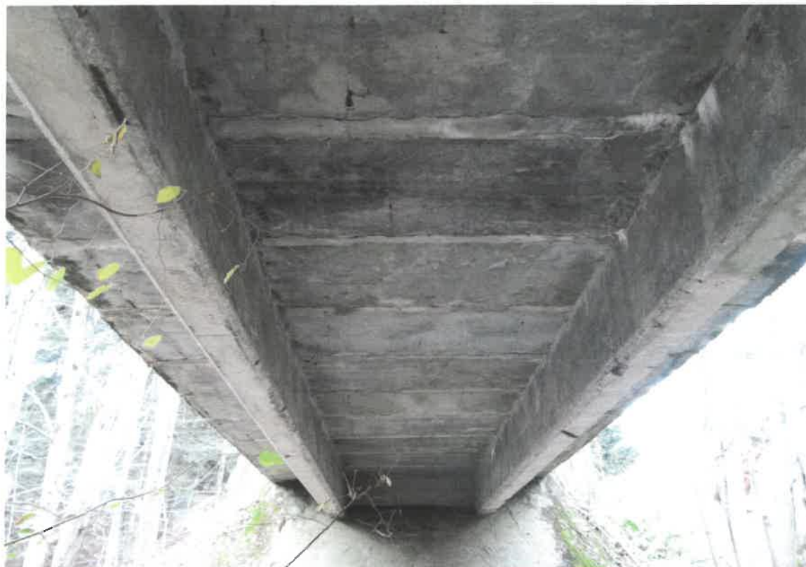
FOT. 1.3 - WIDOK MOSTU OD SPODU
