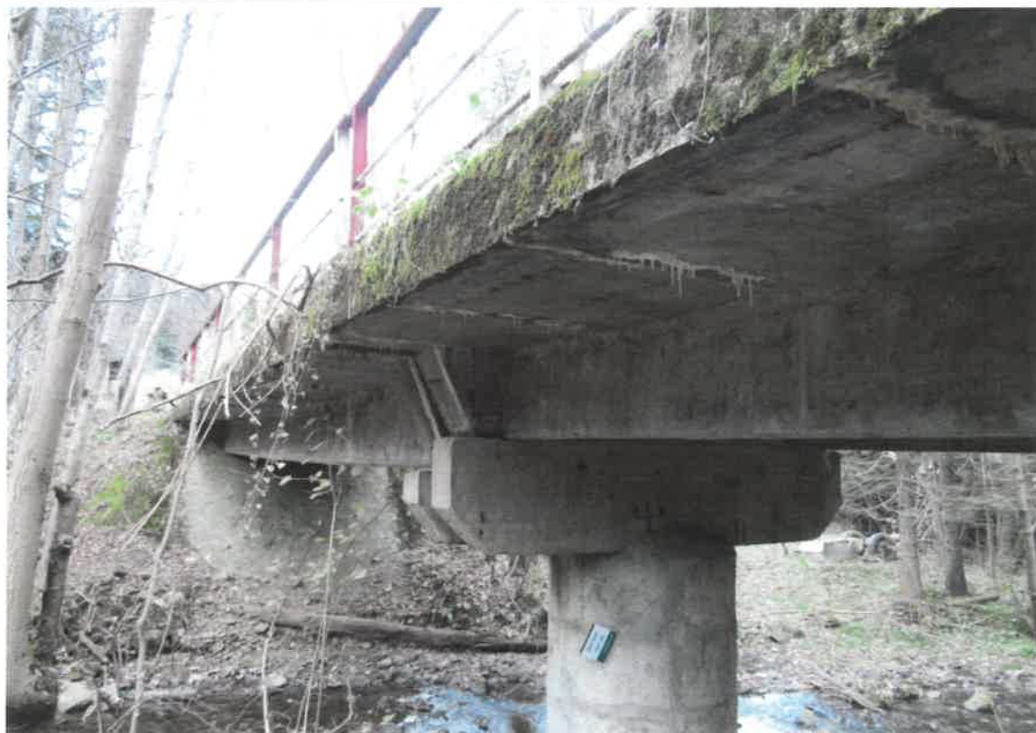
FOT. 1.4 - WIDOK MOSTU Z BOKU
