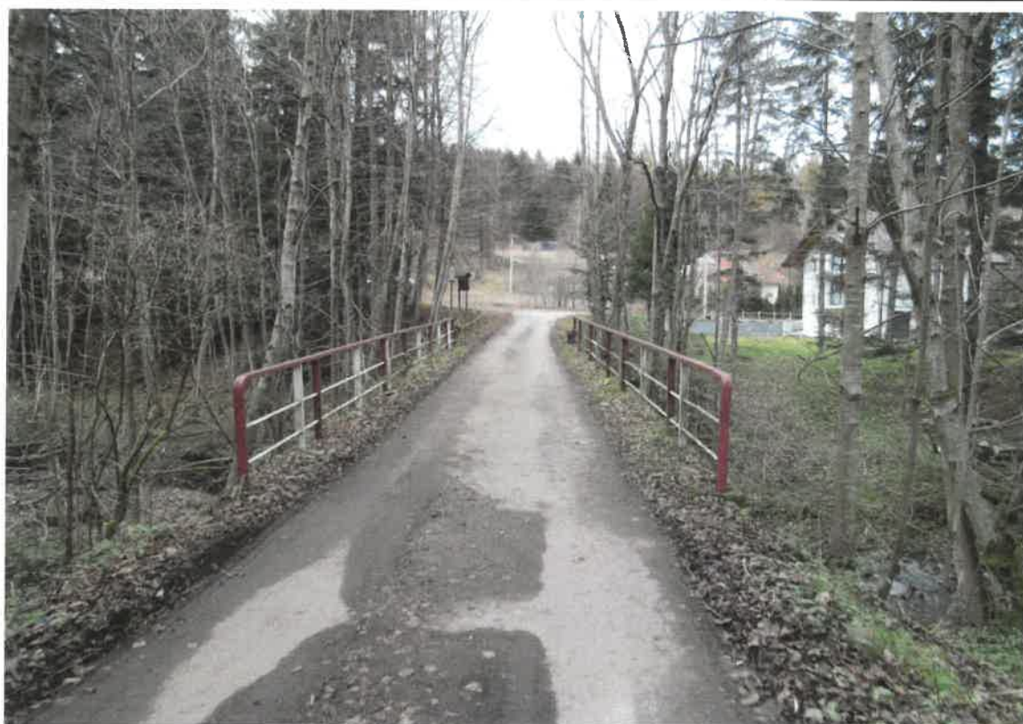
FOT. 1.2 - WIDOK MOSTU Z GÓRY
